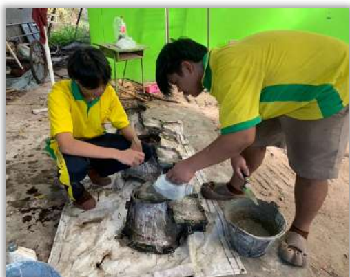
ขั้นตอนการเทปูนใส่แบบแม่พิมพ์
