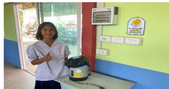
ภาพที่ 3.3.4 การปิดไฟทุกครั้งหลังใช้งาน ภาพหลังดำเนินการ
