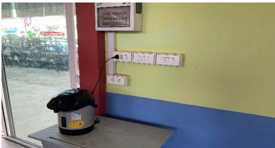
ภาพที่ 3.3.3 การติดตั้งรณรงค์การประหยัดพลังงาน ภาพก่อนดำเนินการ
